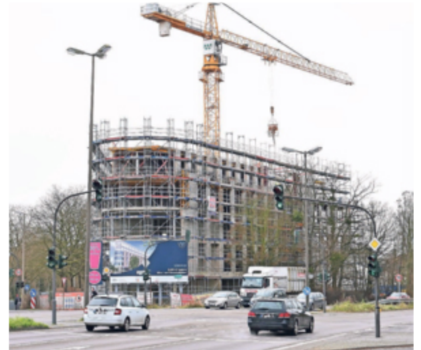
Gegenüber dem Mehlemer Bahnhof lässt die Hafa-Gruppe zunächst das markante Bürohaus entstehen, dann folgen Wohnungen und Gewerbe.
